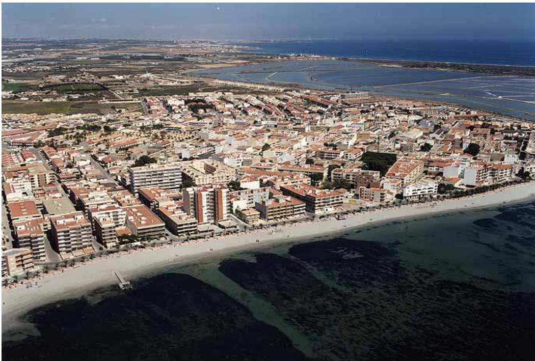
FOTO N° 2: Villananitos (San Pedro del Pinatar)
